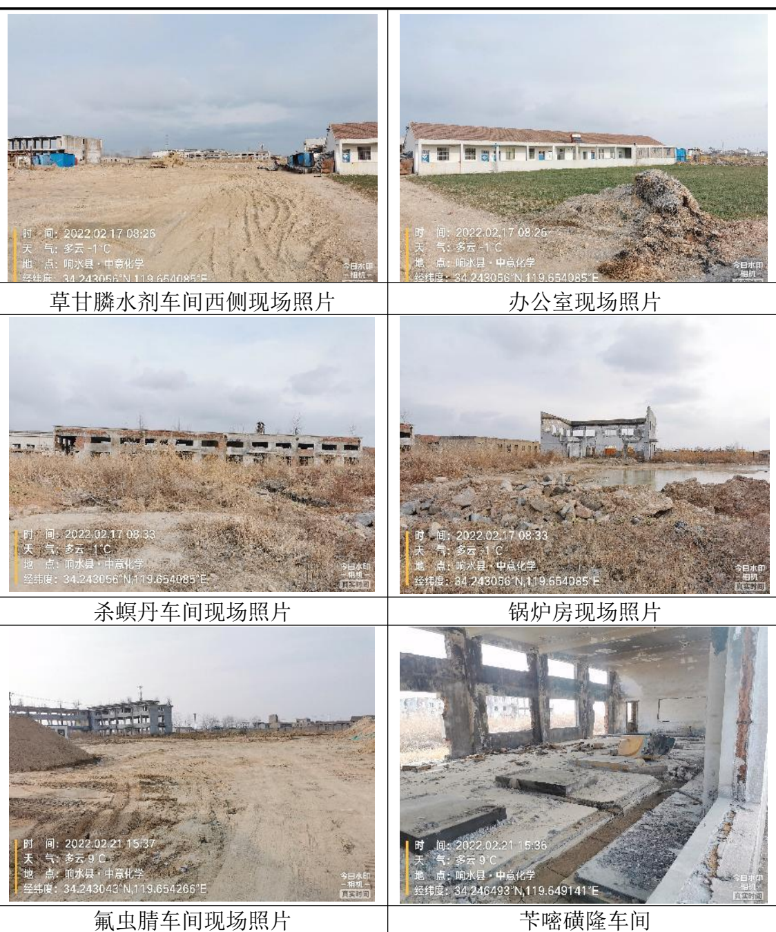
图 3.3.1-1 现场踏勘照片
