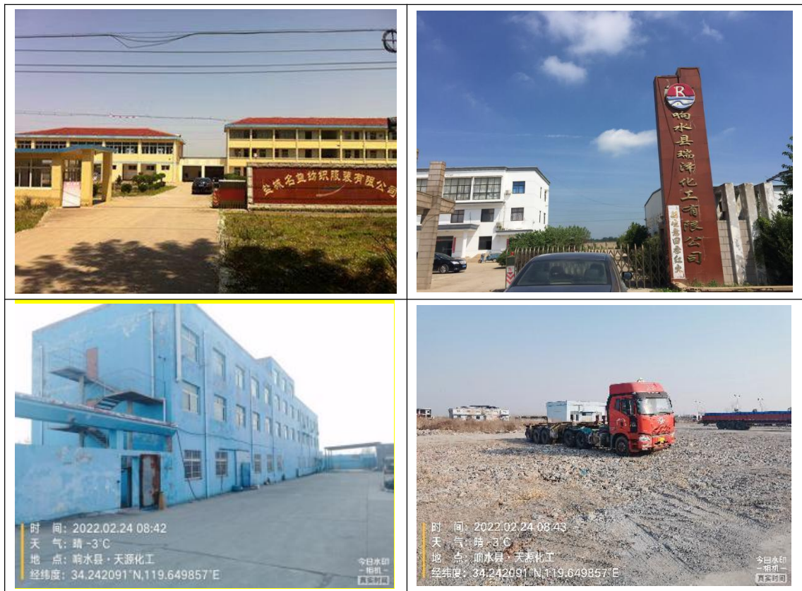
图 3.5.1-2 相邻地块现状图（2022 年 2 月现场踏勘期间）
