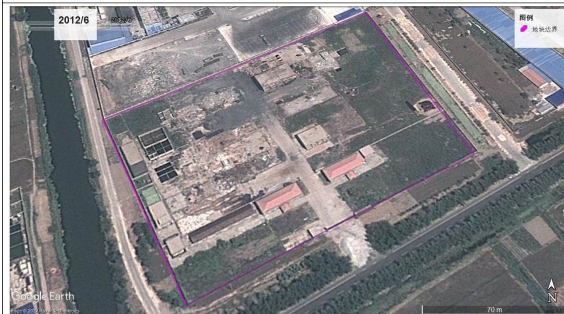
摄于 2012 年 6 月（超晨化工主要生产构筑物已拆除，污水处理区域未拆除）
