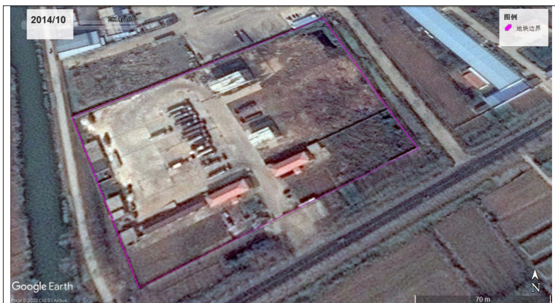
摄于 2014 年 10 月（超晨化工生产构筑物已拆除）
