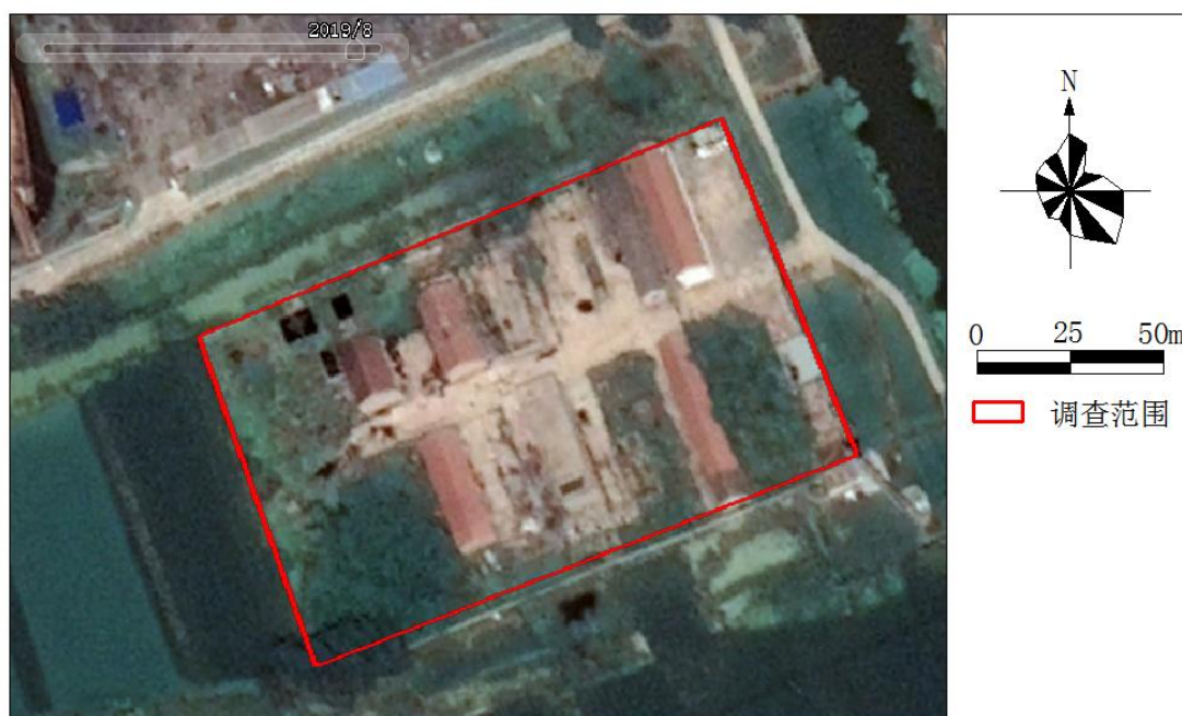
摄于 2019 年 8 月（摘自：谷歌影像）——车间 1 东部墙体已拆除，地块处于闲置状态。
